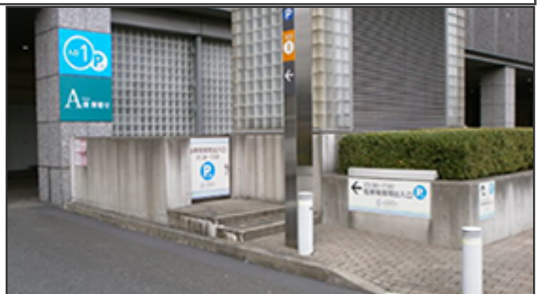
夜間駐車場出入口階段
